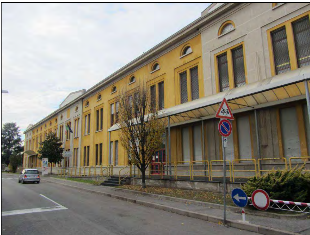
Edificio n. 31 – Via Acerbi
