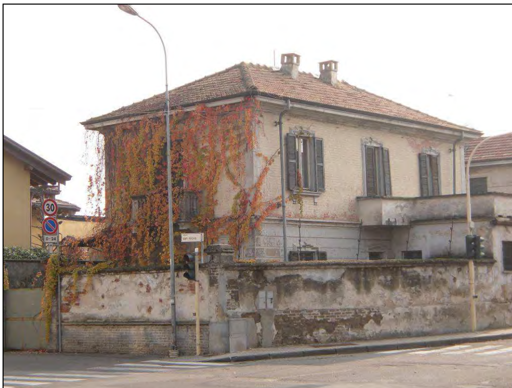
Edificio n. 3 – Corso San Rocco angolo via Vittorio Veneto
