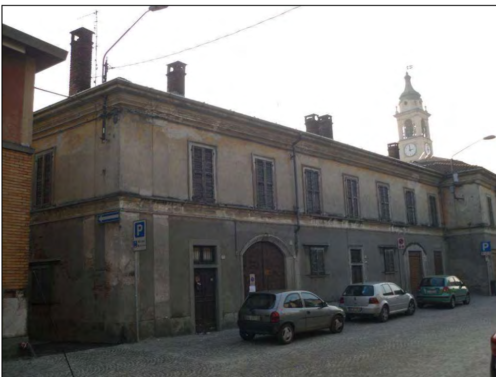
Edificio n. 32 – Corso Martiri Patrioti, 14 – 16 – 18 - 20
