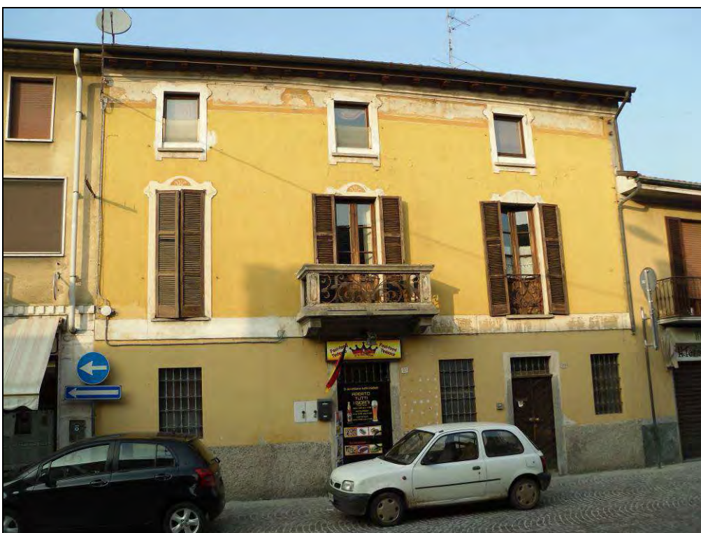
Edificio n. 14 – Corso Martiri Patrioti, 37 - 39
