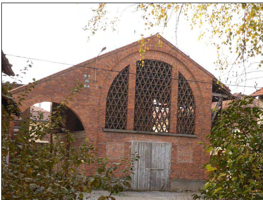
Edificio n. 24 – Via Crocefisso
