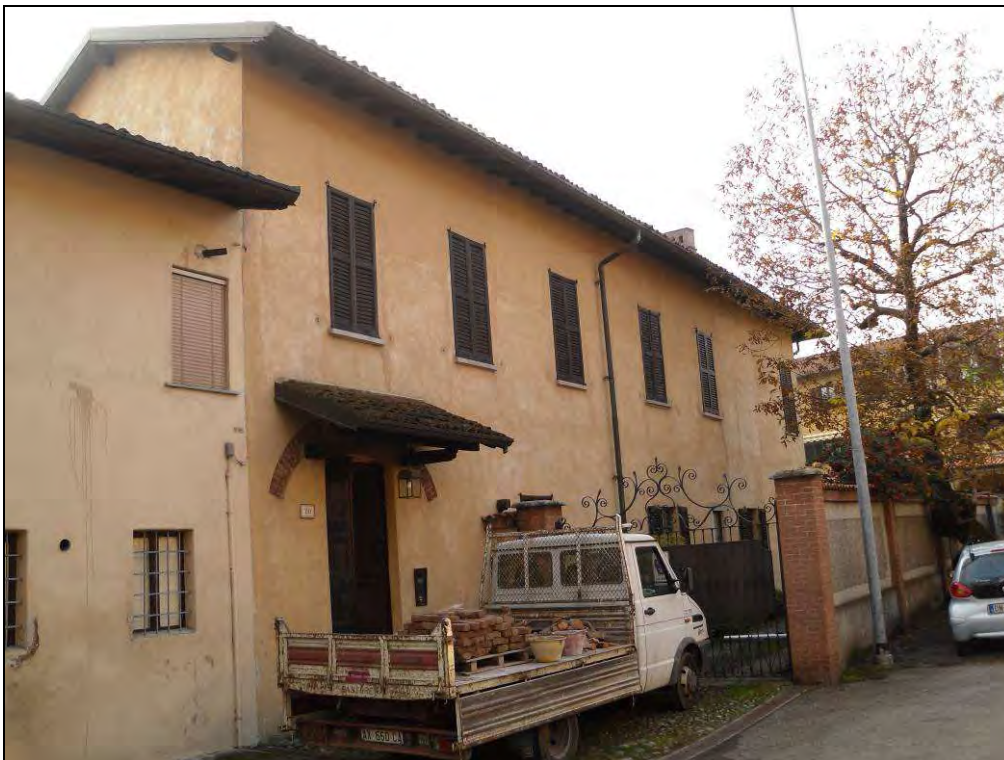
Edificio n. 11 – Via Tobagi,
