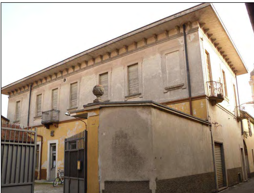
Edificio n. 34 – Via San Gerolamo
