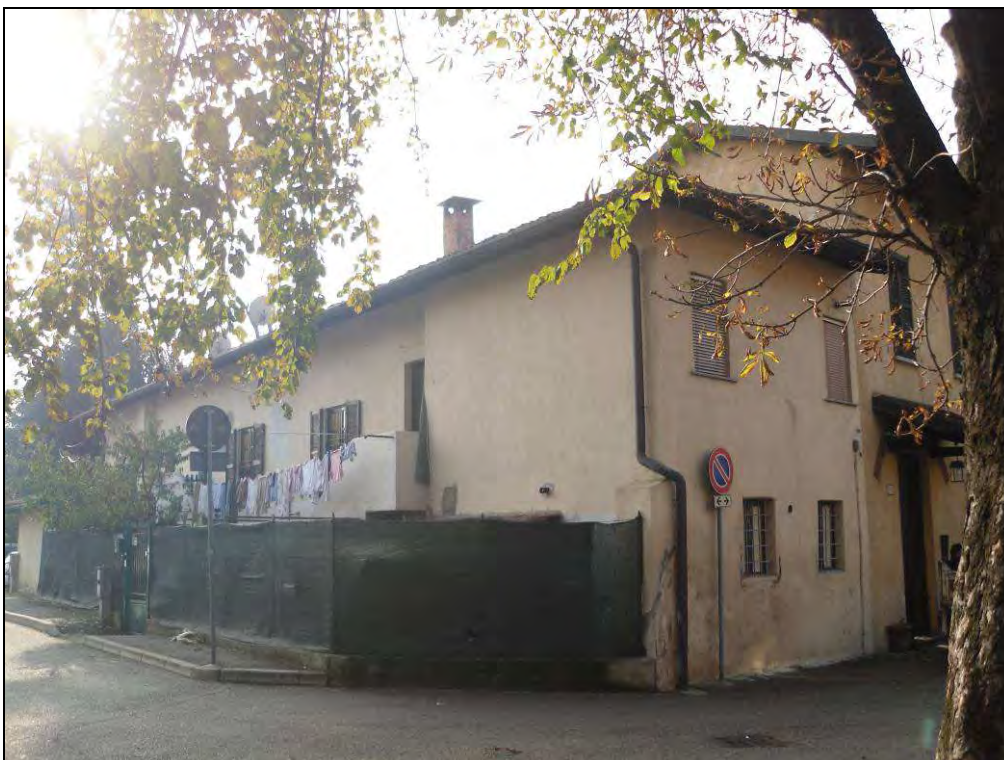
Edificio n. 11 – Via Tobagi,
