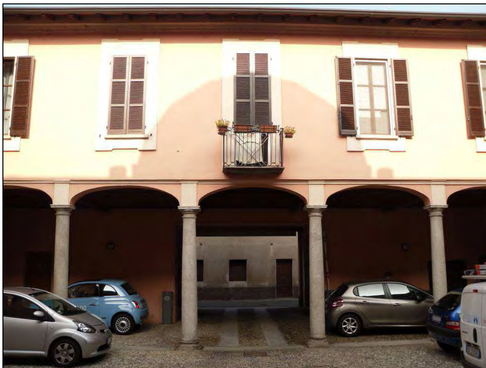
Edificio n. 4 – Corso San Rocco – interno cortile
