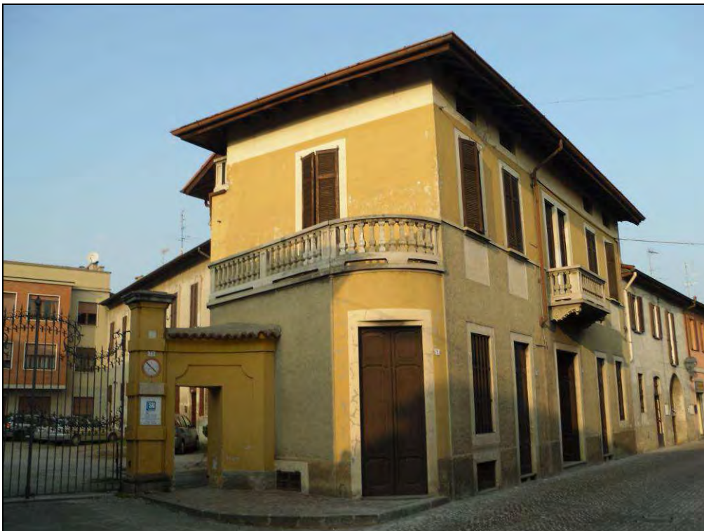
Edificio n. 17 – Corso Martiri Patrioti, 75 -77 – 79 - 81
