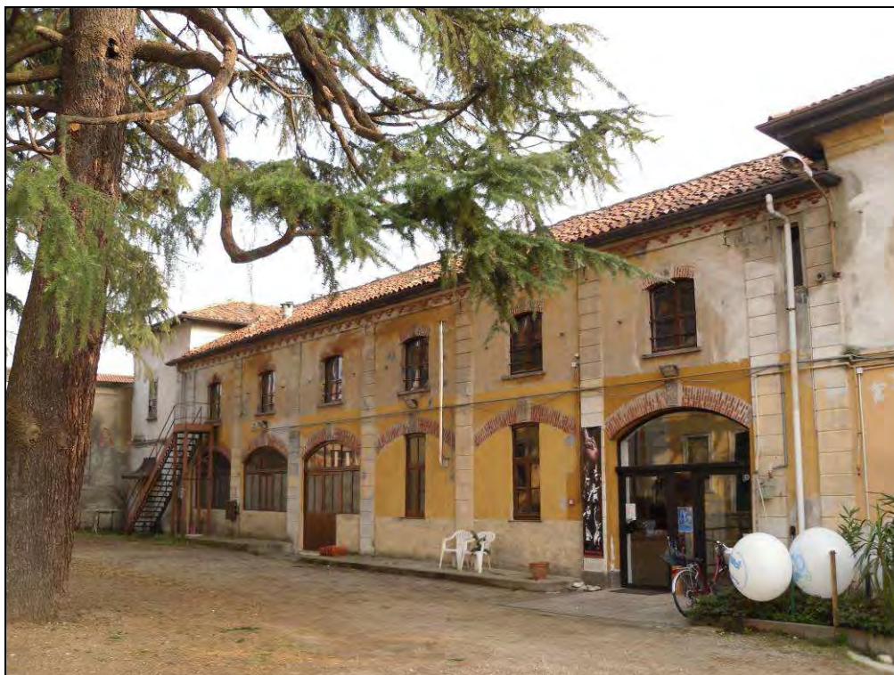
Edificio n. 23 – Via Crocefisso
