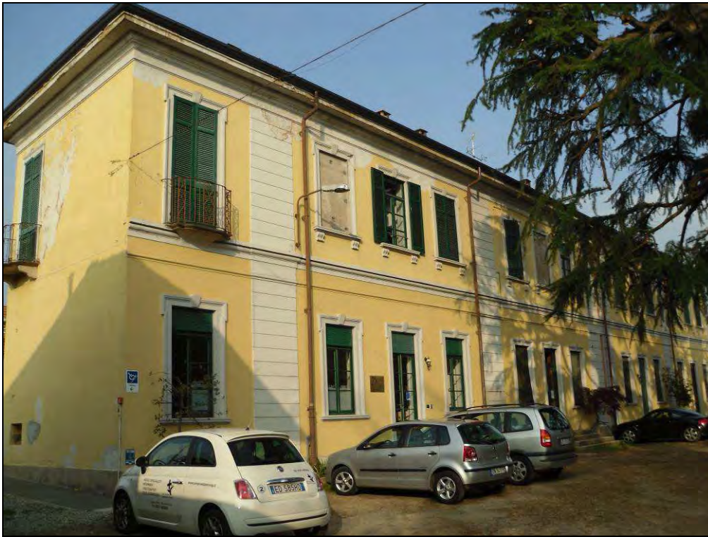
Edificio n. 22 – Via Crocefisso
