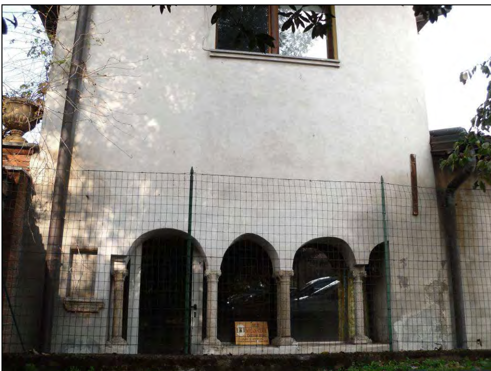
Edificio n. 11 – Via Tobagi,
