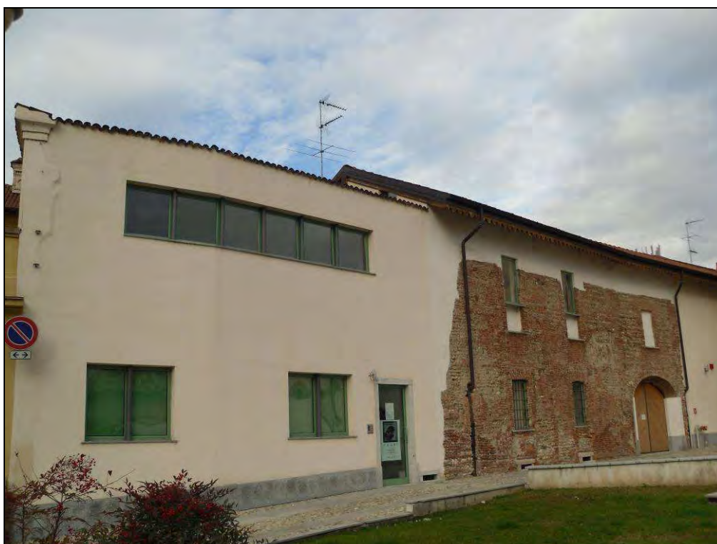
Edificio n. 27 – Via Corio
