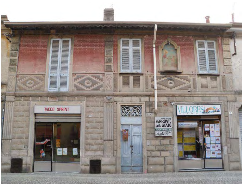
Edificio n. 13 – Corso Martiri Patrioti, 8 – 10 -12
