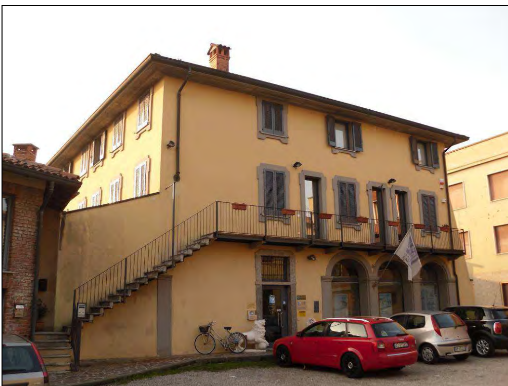
Edificio n. 18 – Corso Martiri Patrioti, con affaccio anche su Via Casati
