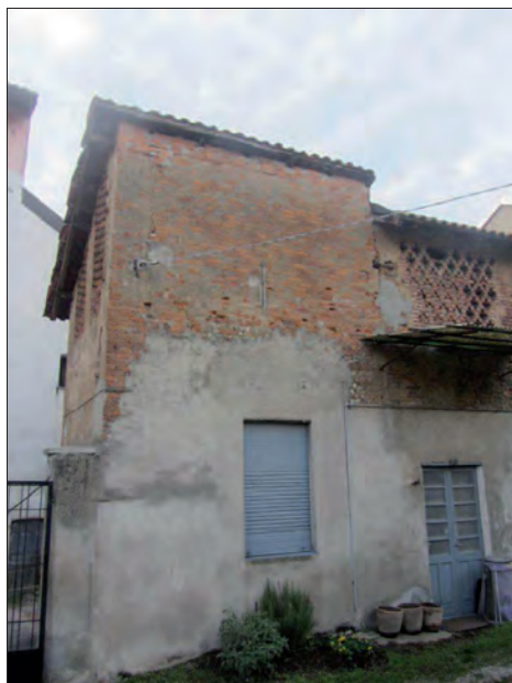
Vista dal cortile n°117
