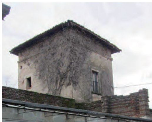
Vista dal cortile n°183
