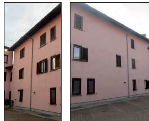
Vista dal cortile n°119
