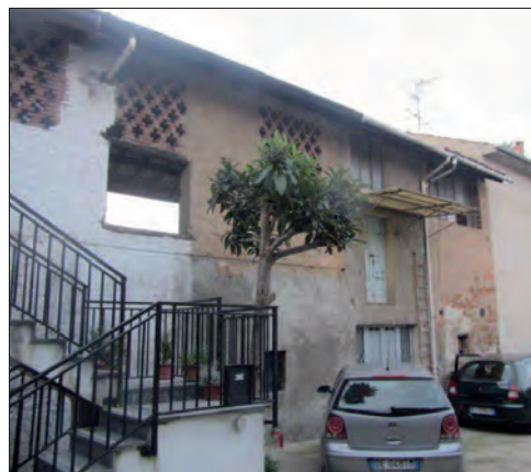
Vista dal cortile n°180
