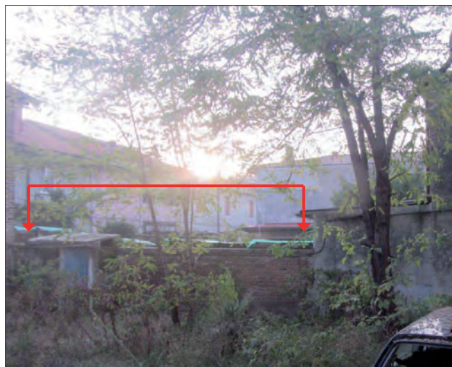
Vista dal cortile n°171
