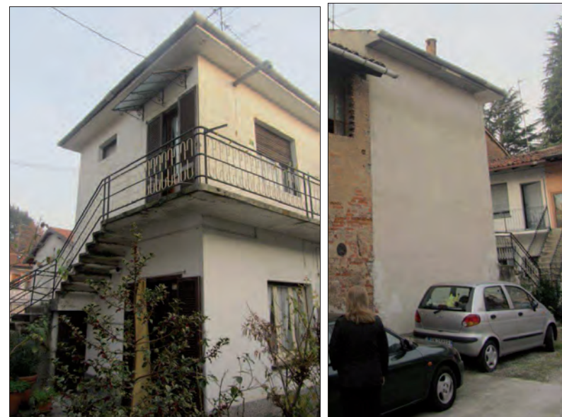
Vista dal cortile n°180
