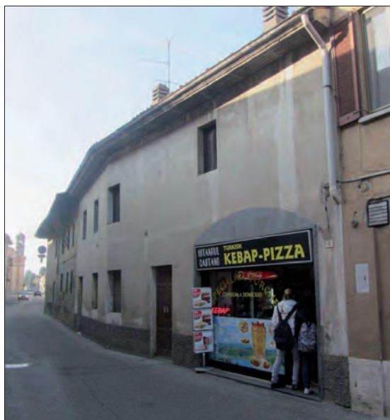
Vista da corso S. Rocco
