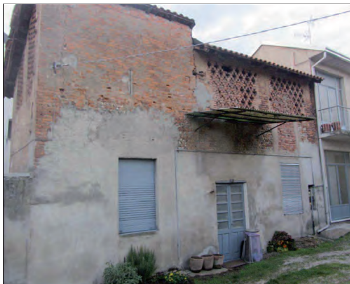
Vista dal cortile n°117
