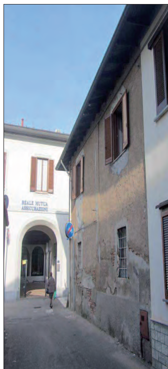
Vista da via Gesù
