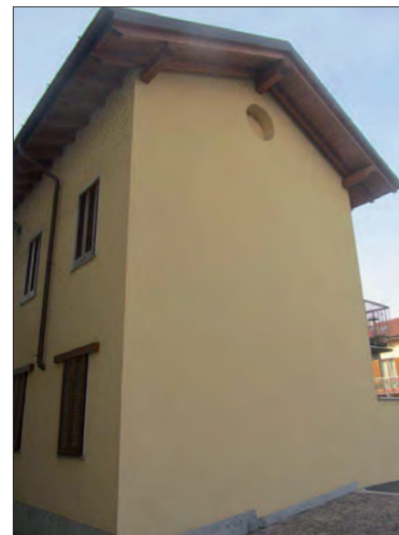
Vista da via Gerolamo angolo via Corio
