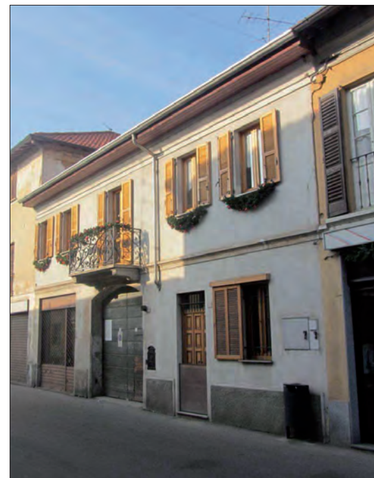
Vista da corso S. Rocco
