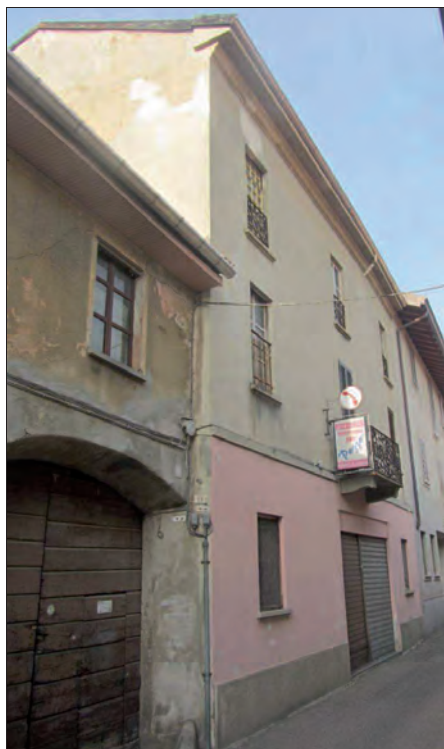
Vista da via Gesù
