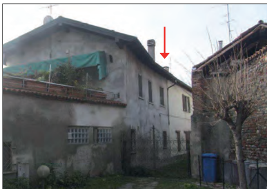
Vista dal cortile n°154
