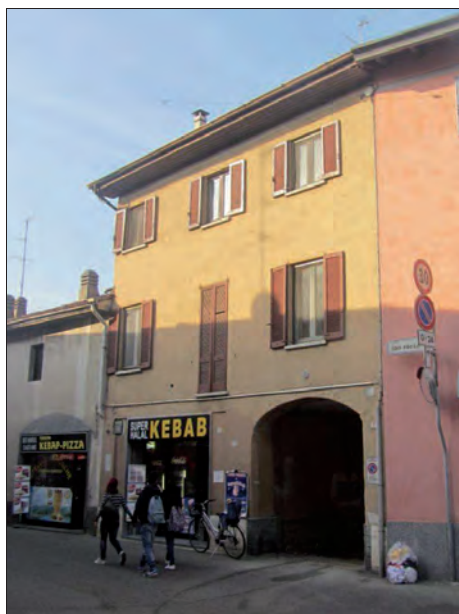
Vista da corso S. Rocco
