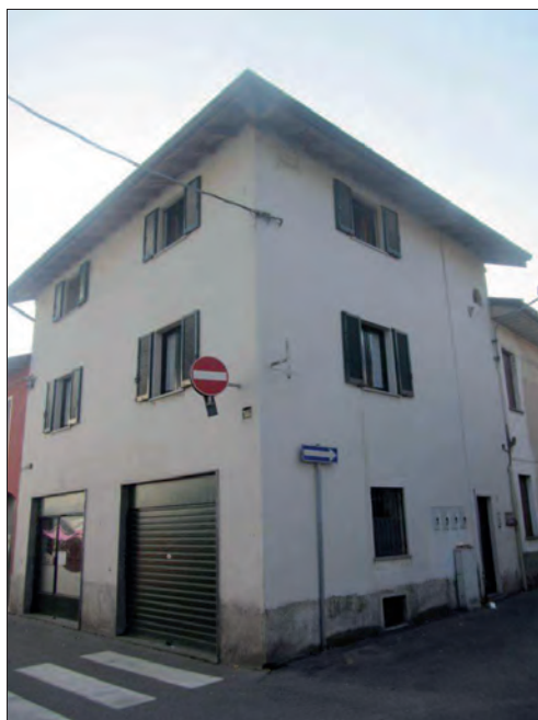
Vista da corso Roma angolo via Diaz
