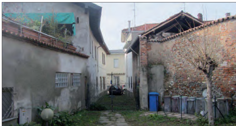
Vista dal cortile n°154
