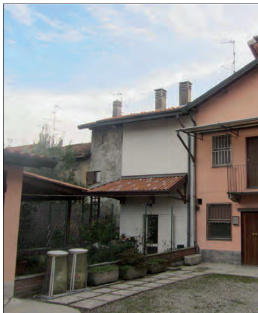
Vista dal cortile n°117
