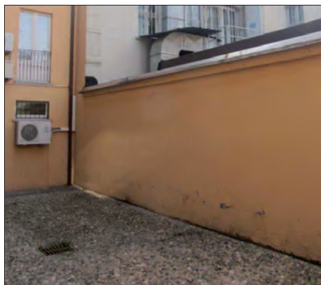
Vista dal cortile n°147
