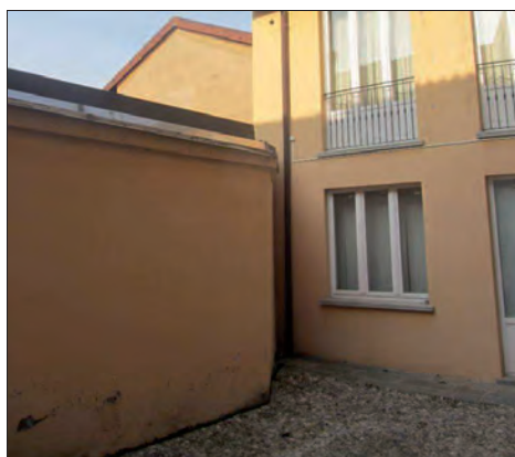
Vista dal cortile n°147
