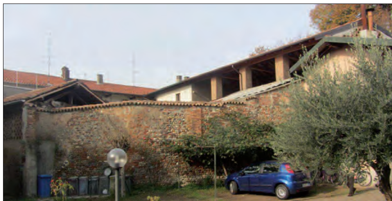
Vista dal cortile n°154
