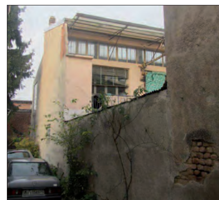
Vista dal cortile n°176
