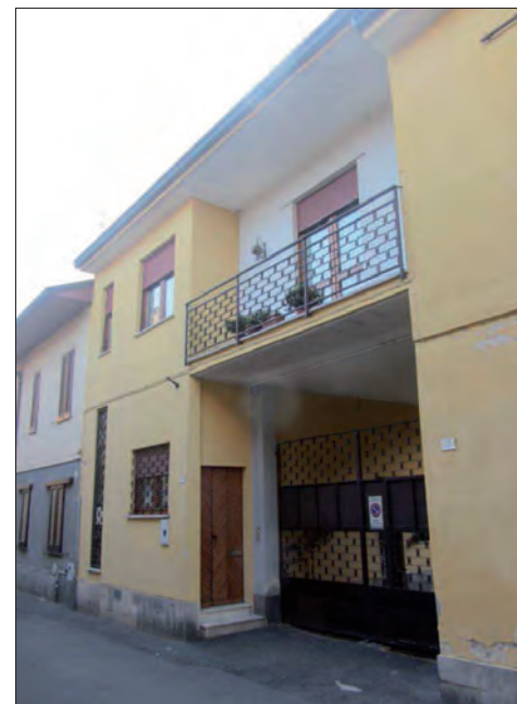
Vista da via Ponte Castano
