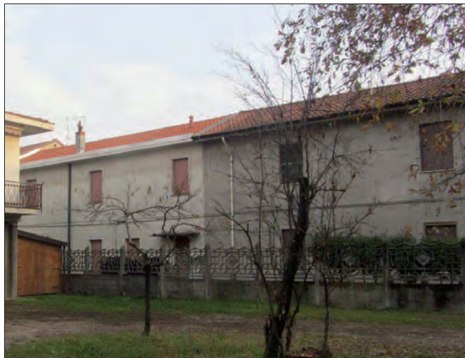
Vista dal cortile n°173
