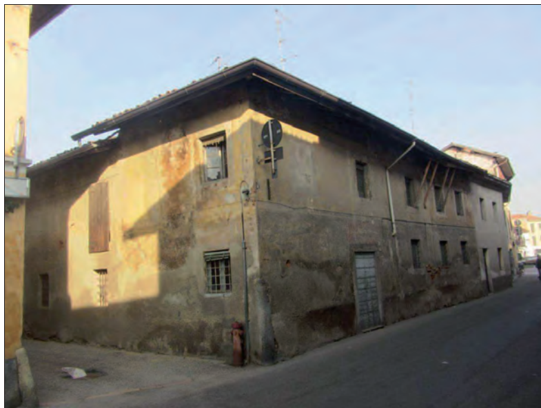
Vista da corso S. Rocco
