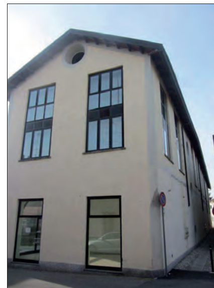
Vista da via S. Gerolamo angolo via Corio
