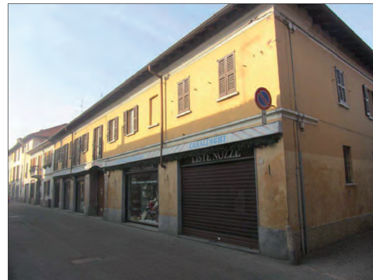
Vista da corso S. Rocco
