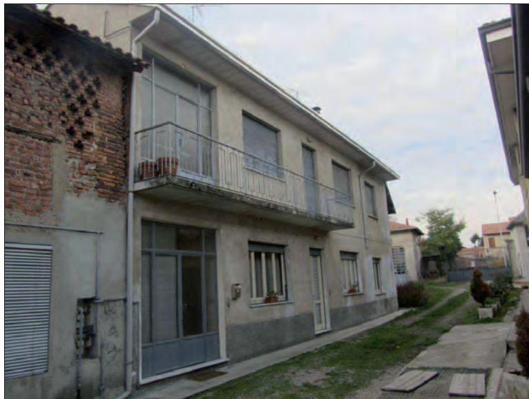
Vista dal cortile n°117
