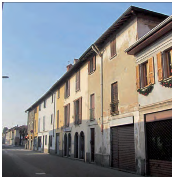
Vista da corso S. Rocco
