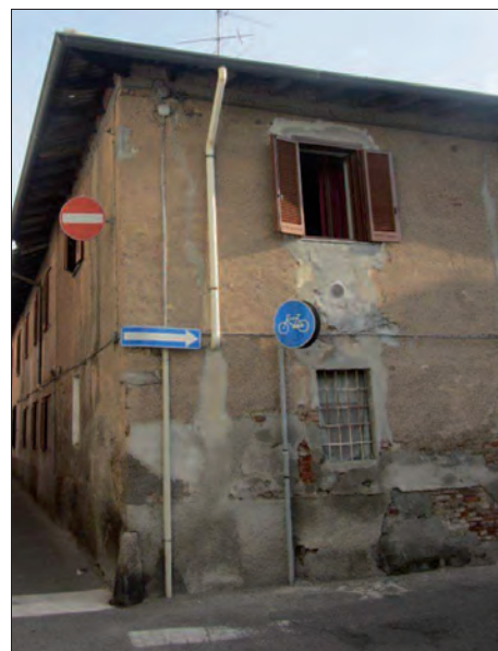
Vista da via Gesù angolo via Palestro
