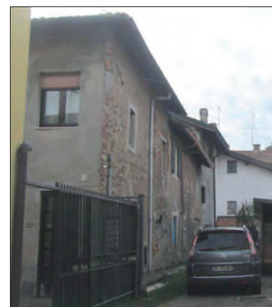
Vista dal cortile n°104
