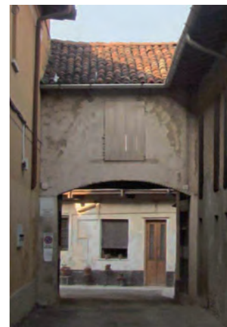
Vista da corso S. Rocco
