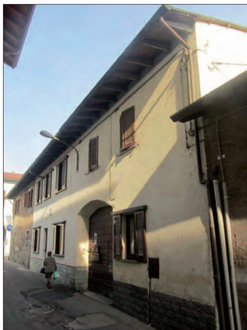
Vista da via Gesù
