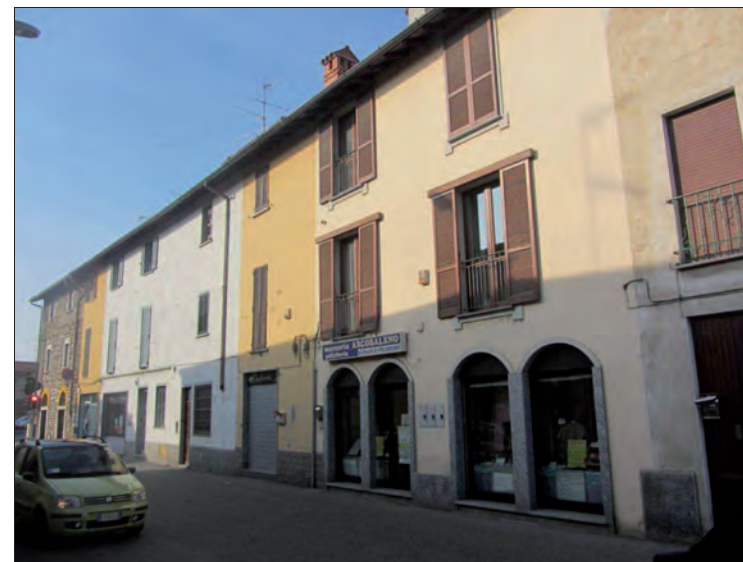
Vista da corso S. Rocco
