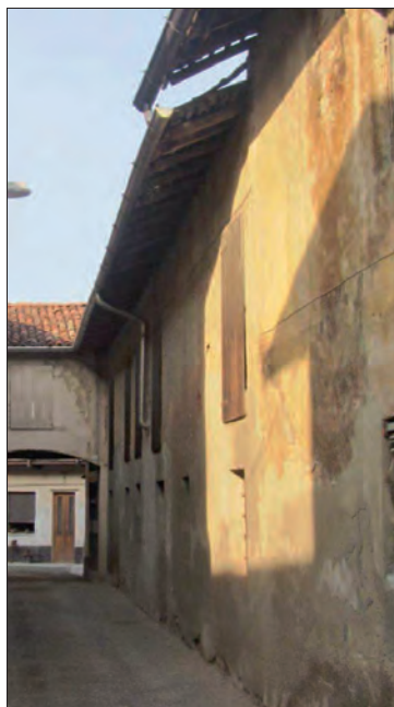
Vista da corso S. Rocco
