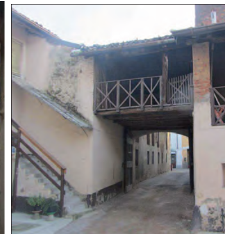
Vista dal cortile
