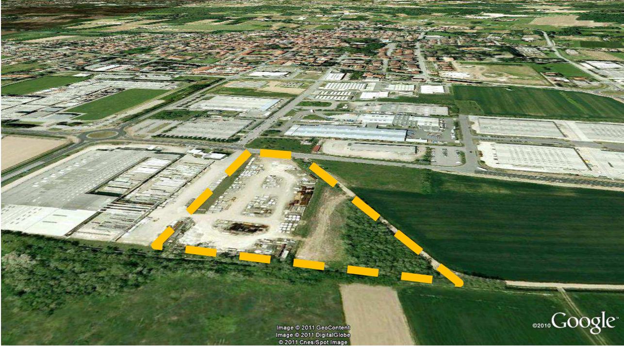
Vista da Sud verso Nord
