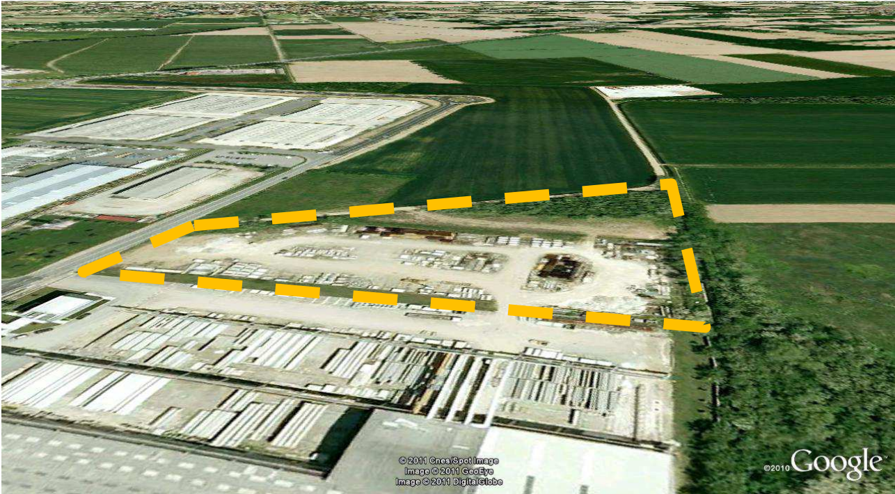
Vista fa Ovest verso Est
